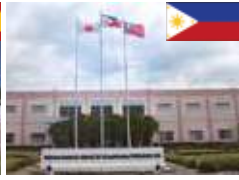
1996 yılında Filipinler'de 5. denizaşırı fabrika
